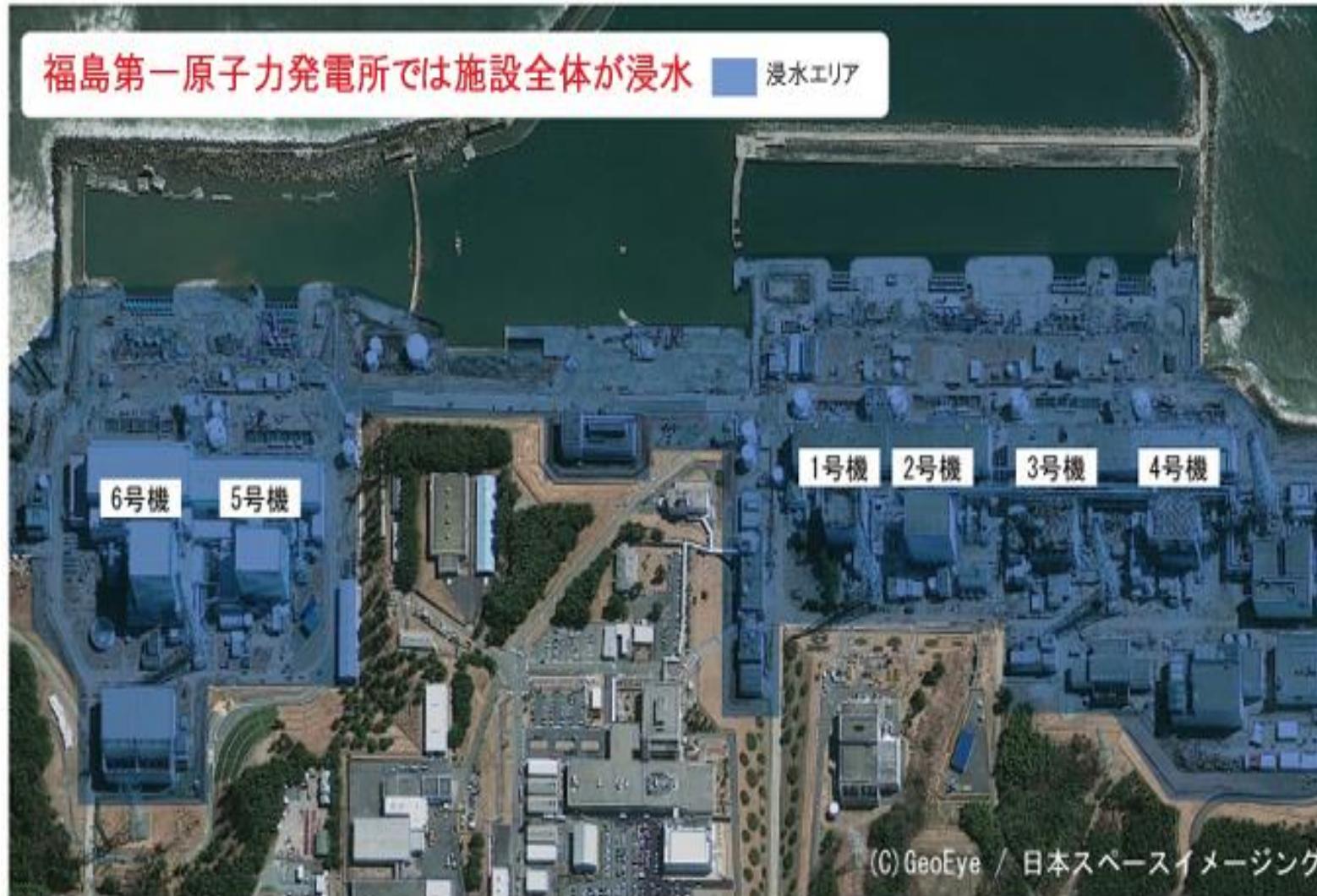
津波による被害を受けた後(全体)の福島第一原子力発電所 2011年3月19日撮影
