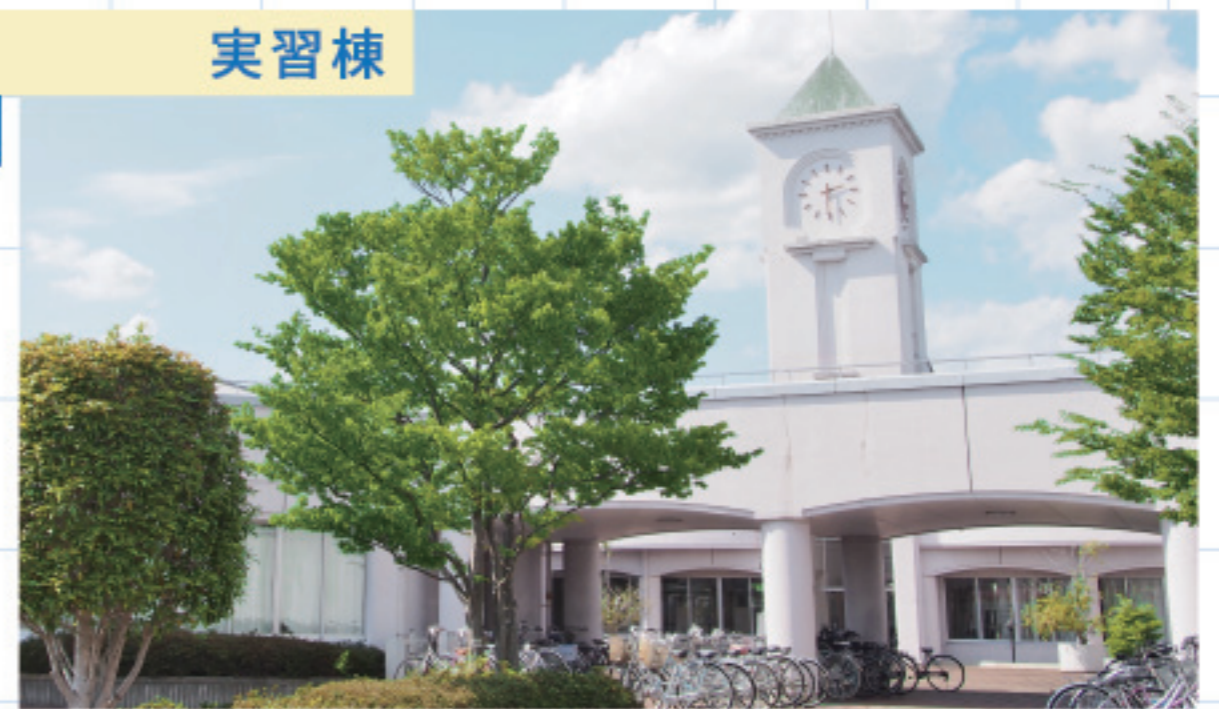
学生玄関、職員室、看護・助産実習室を中心とした実習棟です。
